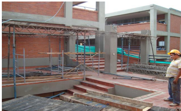
Fuente: Obra Colegio San Carlos
