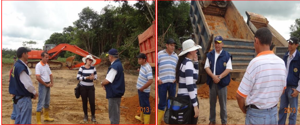
PROYECTO: Visita Técnica OBRAS BARBOSA - VELEZ
