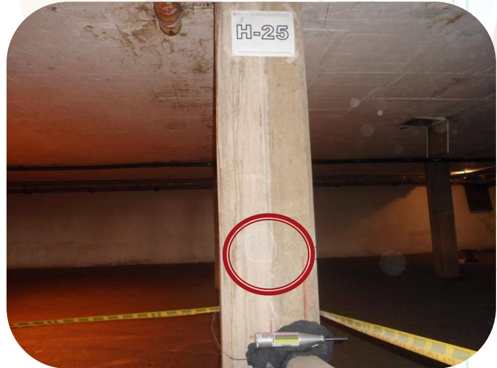
Columnas Parquaderos Estadio
