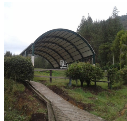
Se desea poder optimizar el uso de esta importante obra
