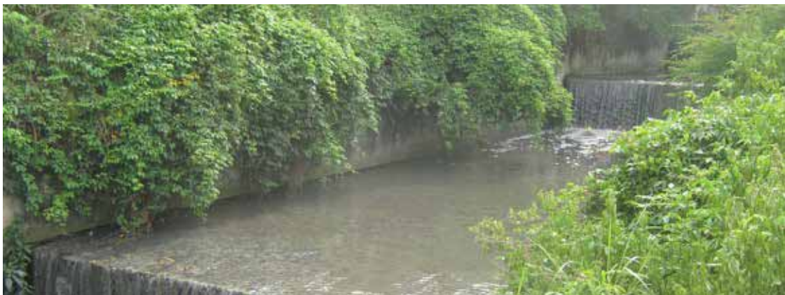
Fotos 14. Vista de vertimiento de la quebrada Chapinero sobre el Río de Oro
