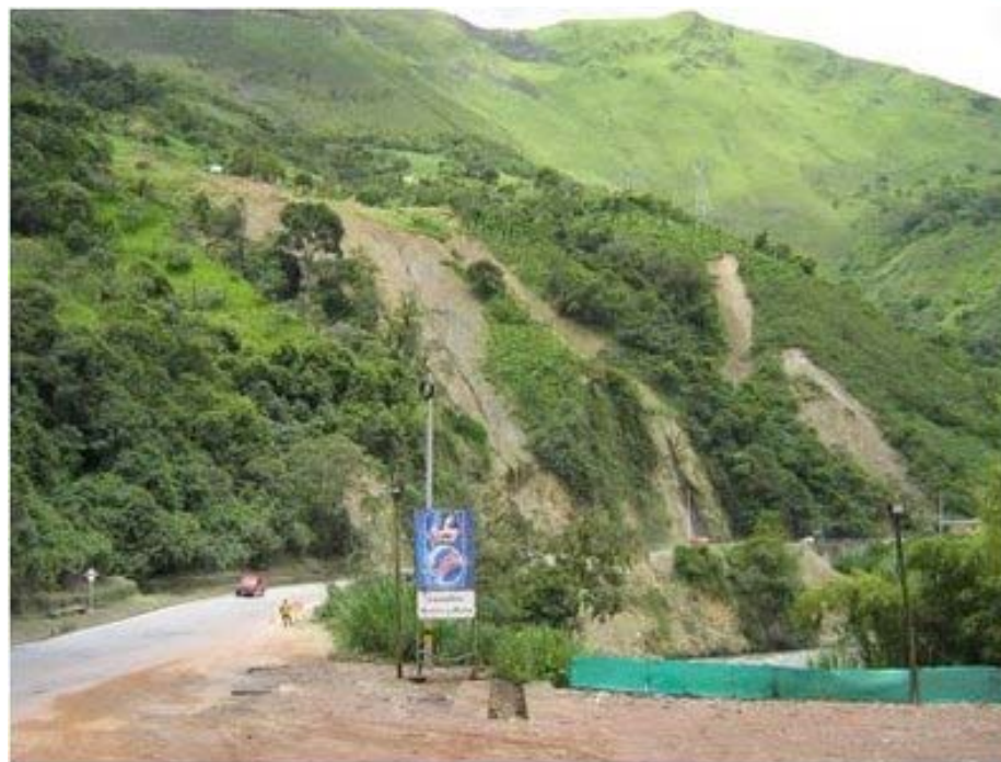
Deslizamientos causados por el sismo
