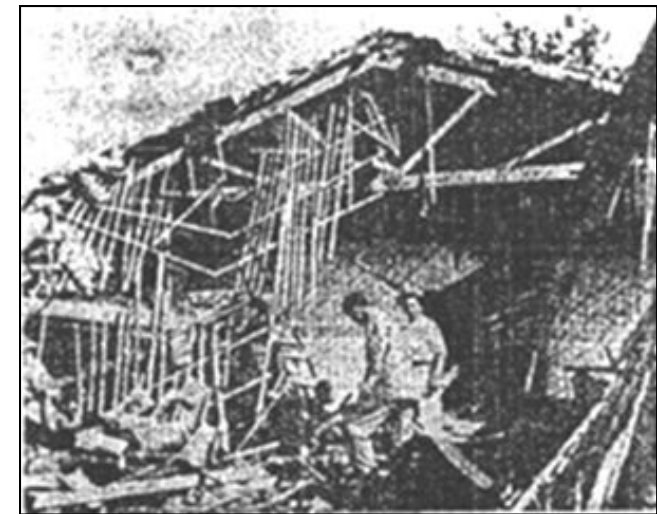
Colapso del Liceo Departamental de Sonsón. Fuente: Diario La Patria.
